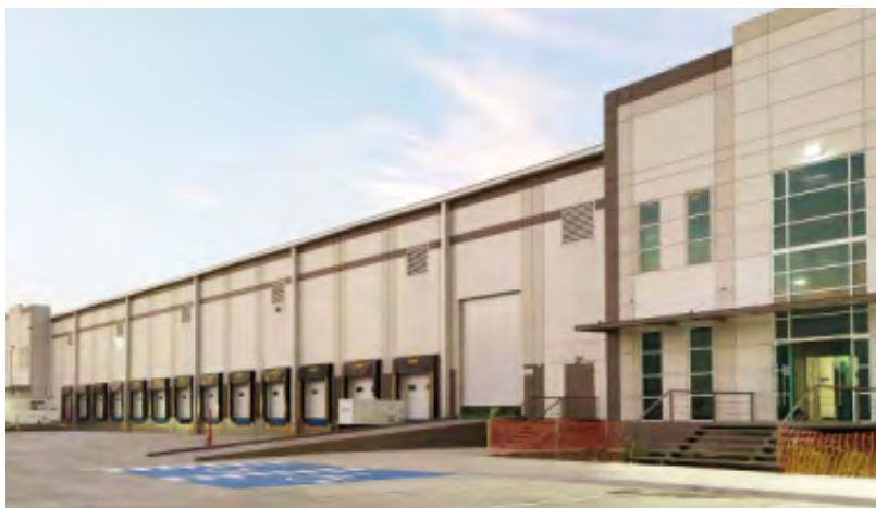
Cedis Ecommerce Monterrey
