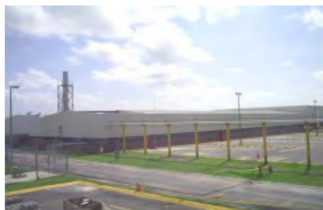
Remodelación de Nave industrial Siemens Guadalajara, Jal.
