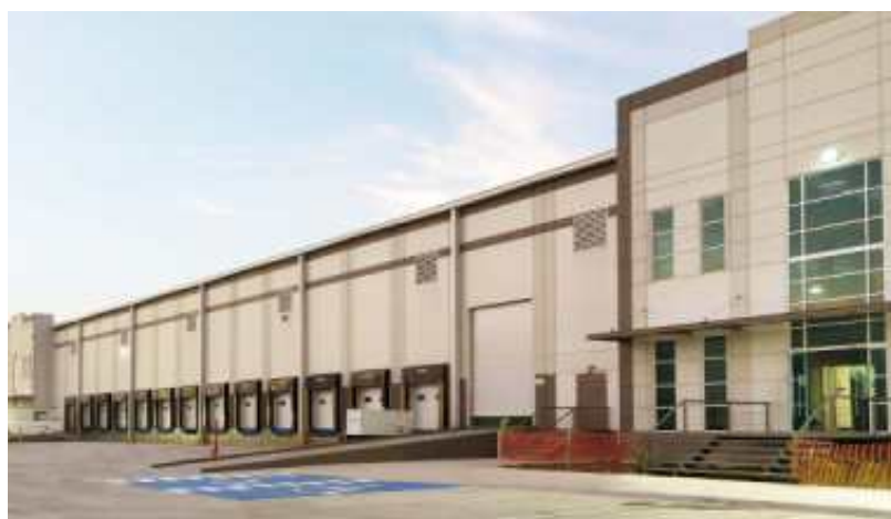
Cedis Ecommerce Monterrey
