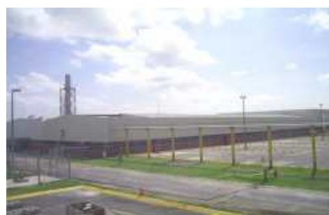
Remodelación de Nave industrial Siemens
