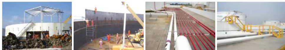
Construcción de tanque, obra civil e instalaciones generales - Poza Rica, Ver.
